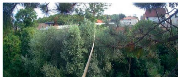
L'écuroduct a été installé en novembre 2023. Il est constitué d'une corde aménagée de chaque côté par des mangeoires afin d'attirer les écureuils sur l'ouvrage et les inciter à l'utiliser pour la traversée de la route. Afin de suivre l'utilisation du dispositif par les animaux, un piège photographique a été installé sur le côté Nord.
