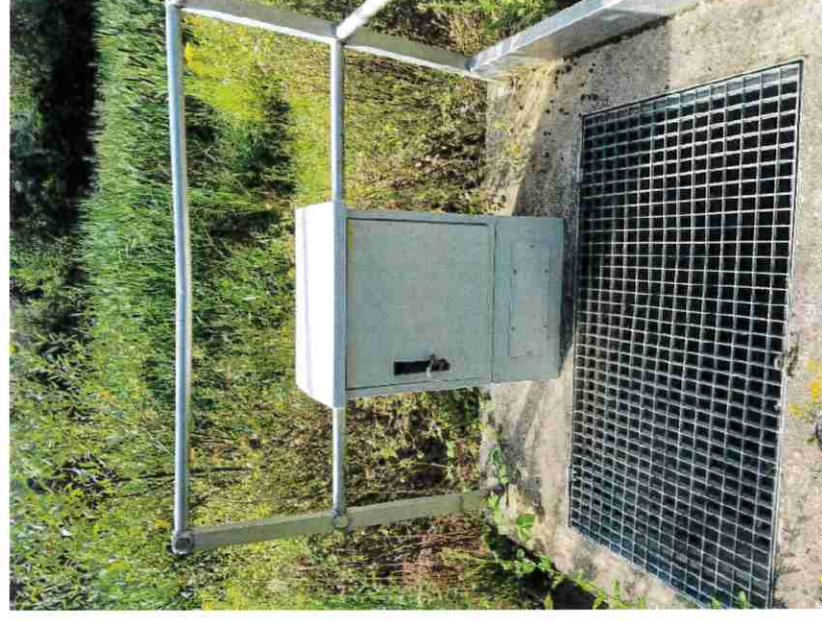
*Poires de niveaux inférieure et supérieur fixées à l'ouvrage cadre + vue sur le masque métallique protégeant la commune contre des occurrences décennales*
