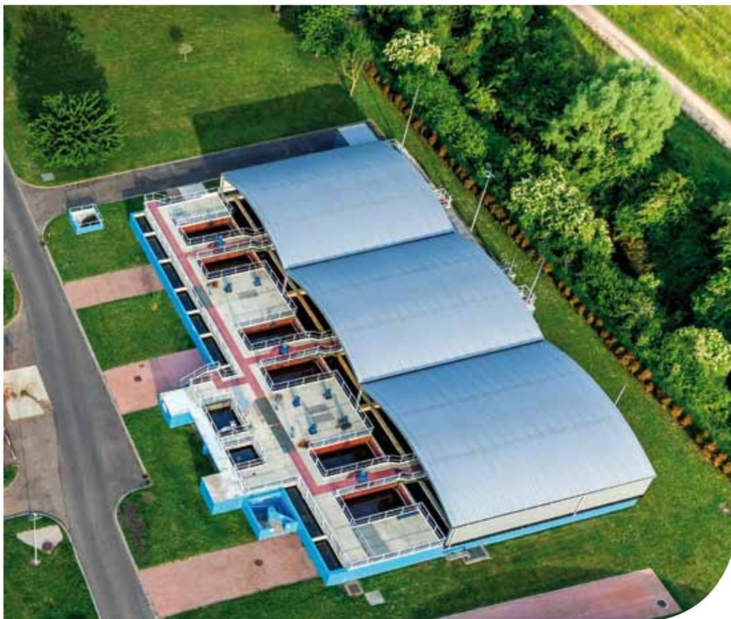
← Le traitement tertiaire permet la déphosphatation des effluents par injection de chlorure ferrique. Il est la dernière étape avant le rejet des eaux à la Moselle.
