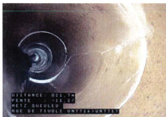
Mauvais état général et fissures
