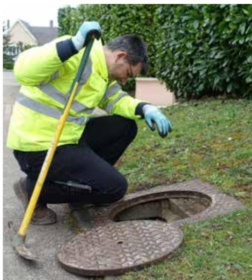
*En mettant un colorant dans les évacuations des habitations, les équipes de Branchements-Conformité vérifient le bon raccordement des habitations au réseau d'assainissement. Ici, à Chieulles.*
