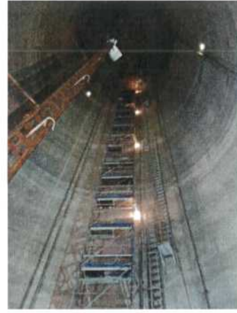
Travaux de réfection sur le réservoir de Marly
