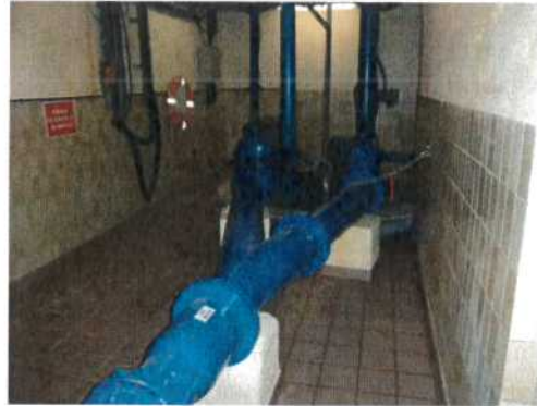
Conduite de refoulement Station R2
