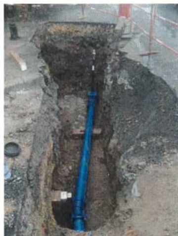
Rue du Canal à Marly
