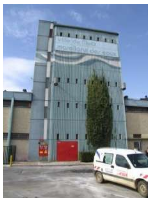
Usine de traitement de Moulins les Metz
