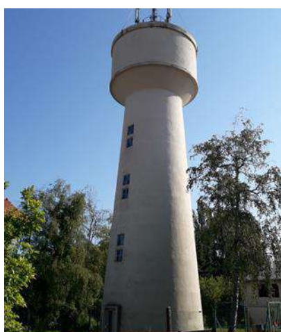
Réservoir de Féy
