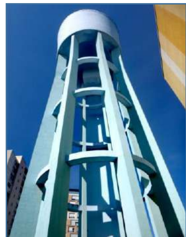
Réservoir de Blorry
