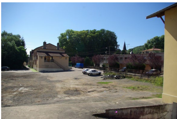
Vue A (2010) – Secteur des travaux en cours
