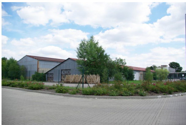
Vue A - Hangars
