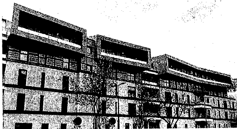
Transformation des anciens bureaux France Telecom rue de Villars à Thionville
