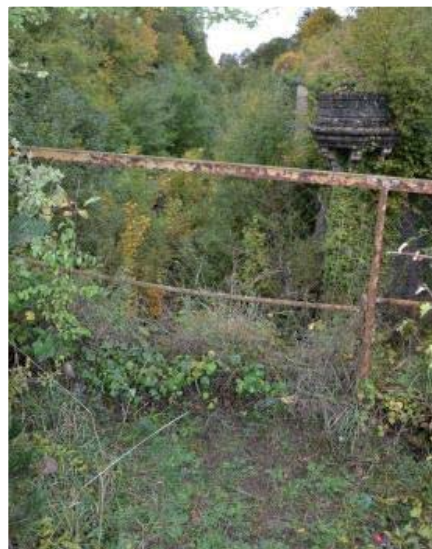
Le garde-corps vétuste sur le mur de contre-escarpe le long de la route
