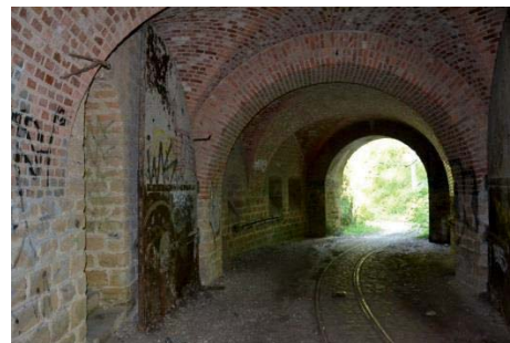
Passage intérieur à l'ouvrage K1
