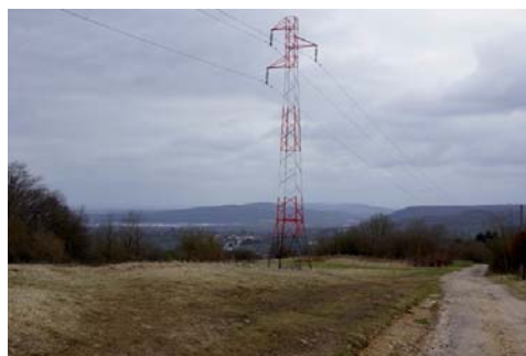
Un des pylônes de la ligne électrique si possible à enfouir (à long terme). Situé dans l'axe d'une vue attractive sur les côtes de Moselle (et rendu très visible par sa peinture rouge et blanche), ce pylône s'avère problématique pour la qualité paysagère de cette vue.
