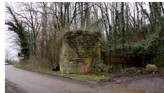
Le seuil d'entrée du chemin en douve montant au fort Girardin depuis la route touristique : dégagement du végétal (arbres et lierre), nettoyage des graffitis et peinture de la grille sont à prévoir.
