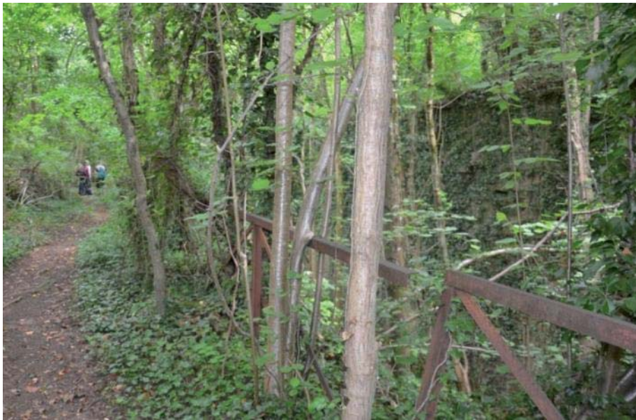
Vue du garde-corps vétuste bordant la douve Sud du fort Diou
