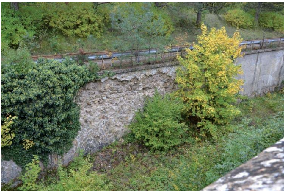
Vue de la zone la plus dégradée du mur de contre-escarpe longé par la route d'accès au fort de Plappeville
