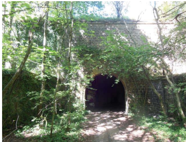
Murs séparant la voie d'accès au fort des douves
