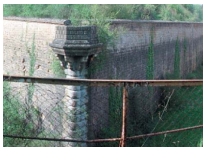
2005 : bastion Sud-Est fort Plappeville (photo CETOBA/ Atelier Patrimoine et Paysage)
