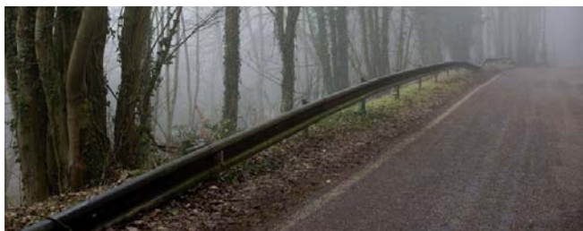
Glissière de sécurité en métal visible le long de la route touristique, à remplacer (voire si possible, à supprimer).
