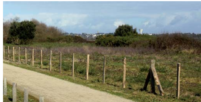
Exemple de clôture barbelée aménagée le long d'une circulation piétonne, dans un site à caractère naturel (pointe de Pen-Bron, dans le site classé des marais salants de Guérande), afin de protéger des milieux naturels sensibles du piétinement.
