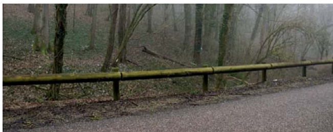
Exemple de glissière en bois, d'aspect mieux adapté à un site naturel et classé (D51 à Lorry-lès-Metz)
