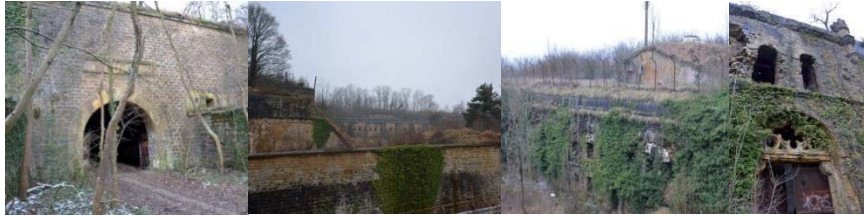
Accès au groupe St Quentin Fort de Plappeville Fort Diou Caserne St Quentin
