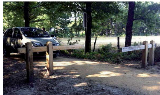
Exemple de contrôle d'accès assuré par une double barrière forestière (source photo : abc-collectivites.com)
