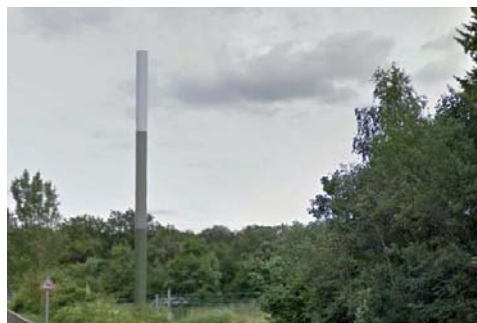
Exemple de pylône monotube (radôme), un type d'antenne-relais dont l'intégration paysagère est, en contexte naturel, bien meilleure que celle des antennes-relais communément installées.
