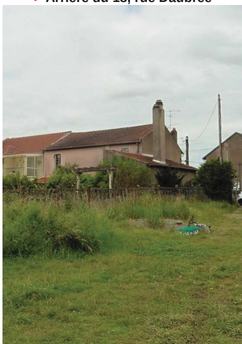
> Arrière du 18, rue Daubrée
