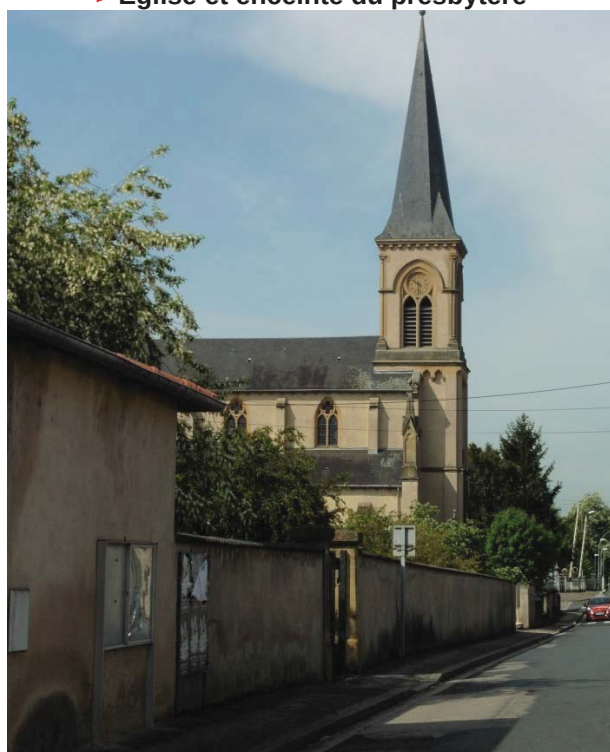
> Eglise et enceinte du presbytère
