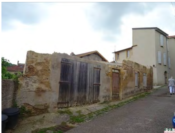
Bâtiment en ruine, attenant à une habitation
