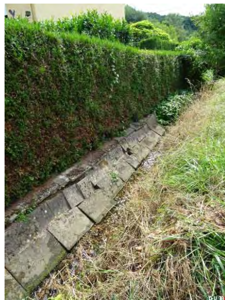
Berges du Bord du Rupt consolidées au niveau de la Rue du Bord du Rupt
