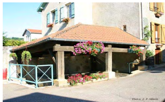
Lavoir communale situé rue Pasteur
