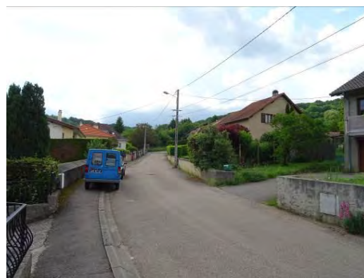
Rue Jeanne d'Arc, trottoir peu large et stationnement opportun sur le parcours piéton
