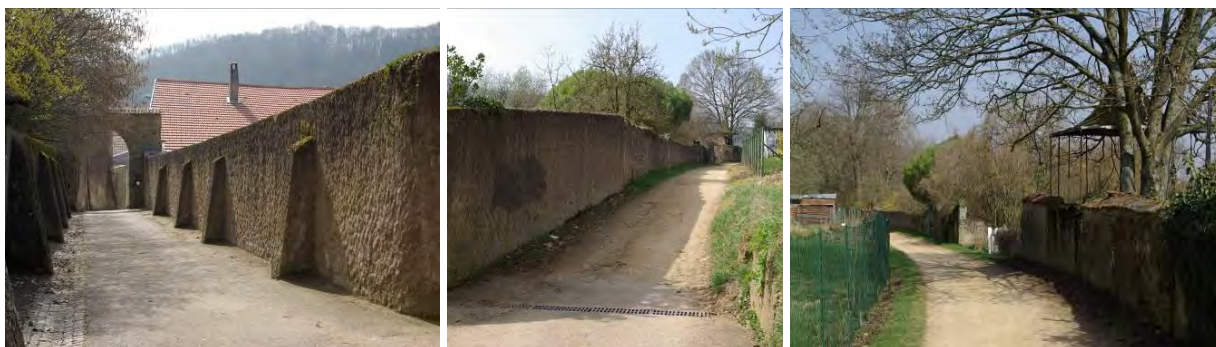
Chemins ruraux entourés de hauts murs autour du village
