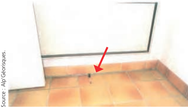
Affaissement du plancher mis en évidence par le décallement entre plinthes et dallage - Maison Jourdan.
