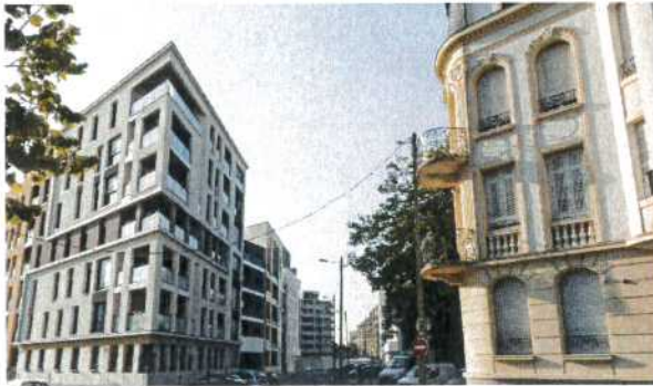
Réhabilitation de la friche Hospitalière Bon Secours
