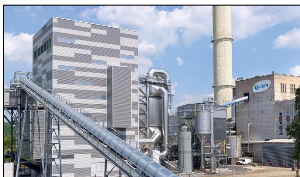
Figure 13 : Centrale de Metz-Cité (Chambièrre), unité de production à biomasse au premier plan
