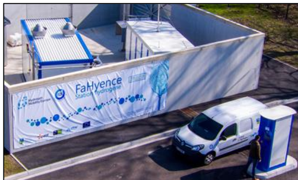
Figure 8 : La station de production et de distribution d'hydrogène de Sarreguemines
