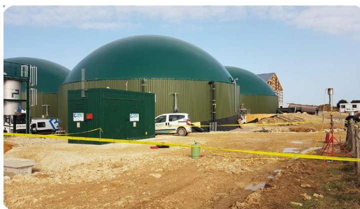
Figure 9 : Unité de méthanisation située à Augny
