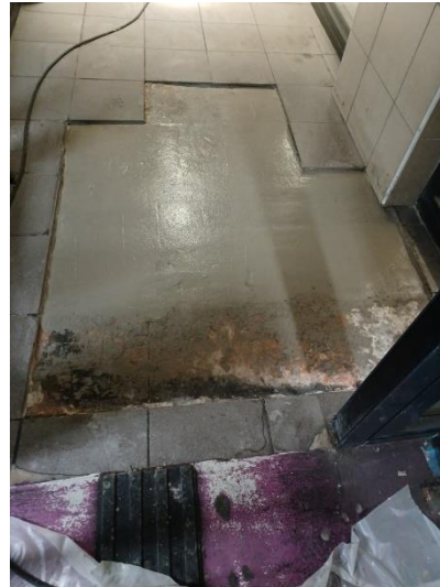
Figure 2 – Réparation au mortier
