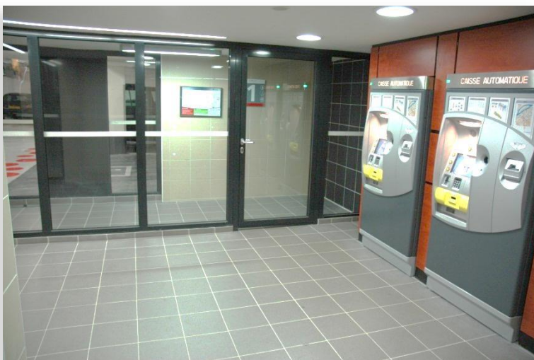
< Zone de paiement niveau -1, panneaux d'habillage des caisses, carrelages et sas vitrés.
