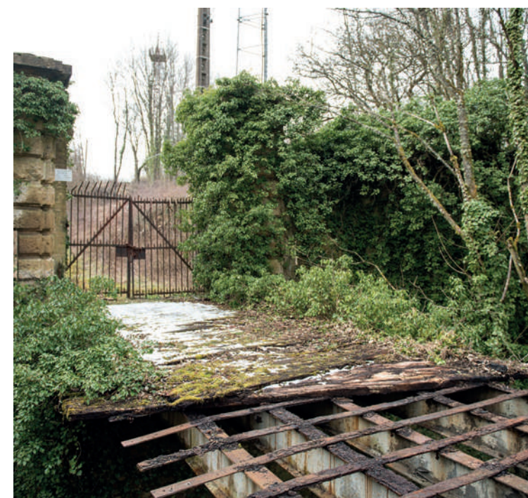
La passerelle d'accès au Fort Diou, entièrement sécurisée, surplombe le fossé sec entourant l'ouvrage
