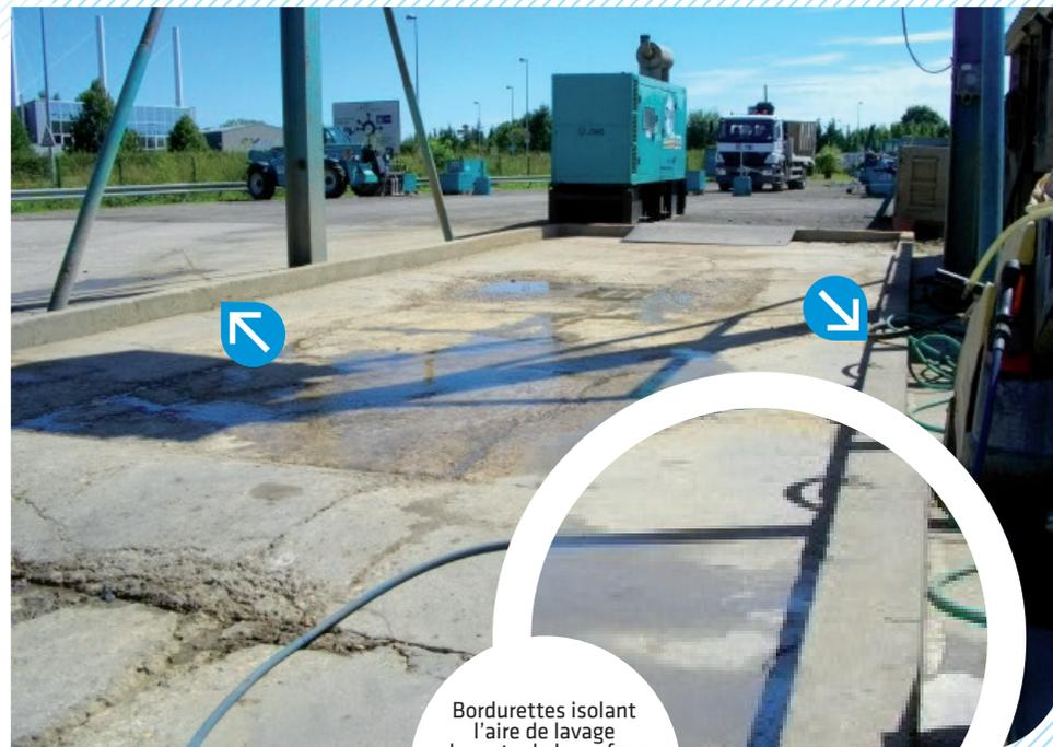
Bordurettes isolant l'aire de lavage du reste de la surface au sol. PAS de contact entre les eaux de lavage et les eaux de ruissellement extérieures
