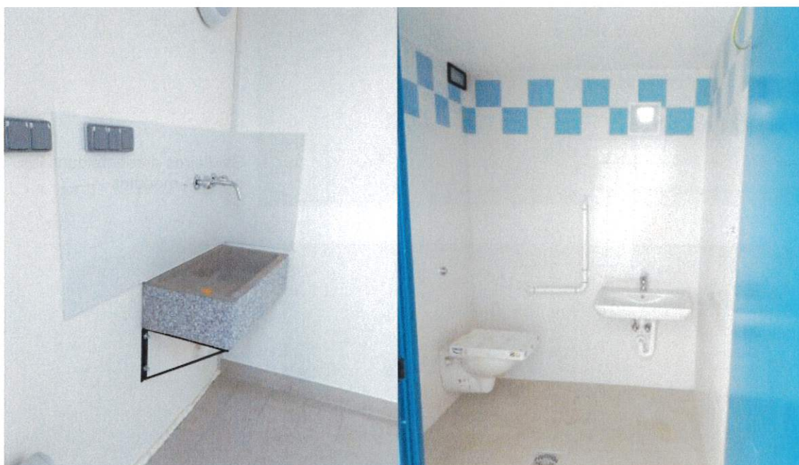
Sanitaires WC et buanderie intérieure présents dans l'ensemble des modules
