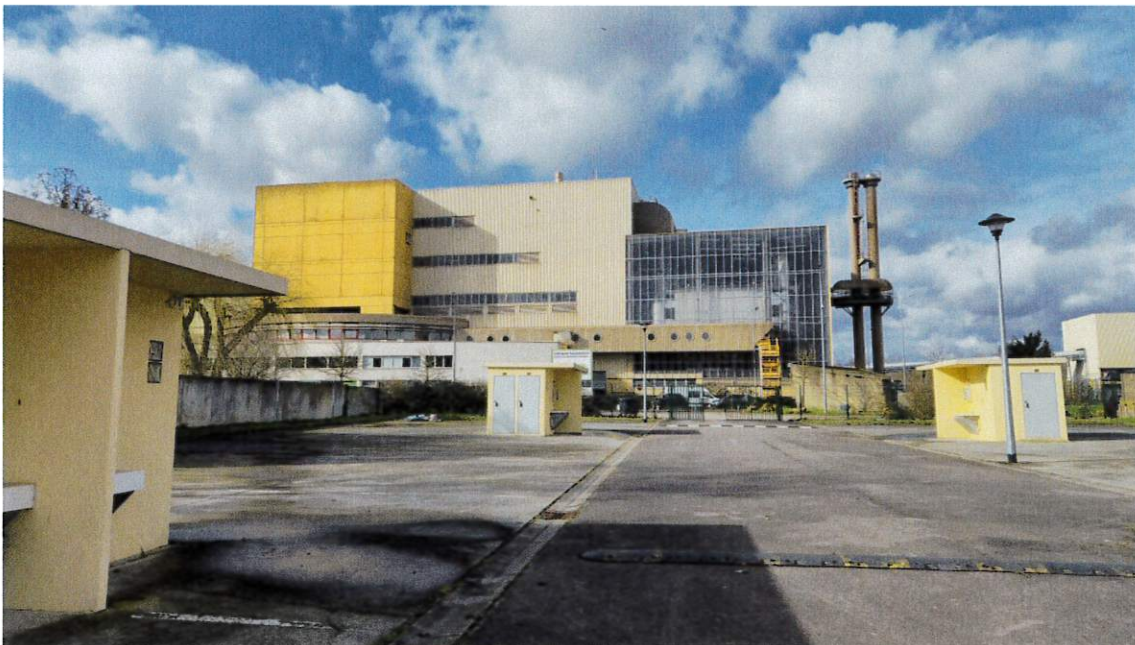
Entrée n°2 de l'aire d'accueil de Blida qui se situe en face du centre d'incinération HAGANIS
