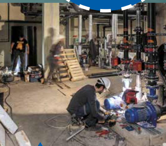
Raccordement des pompes pour procéder aux tests techniques cette rentrée.
