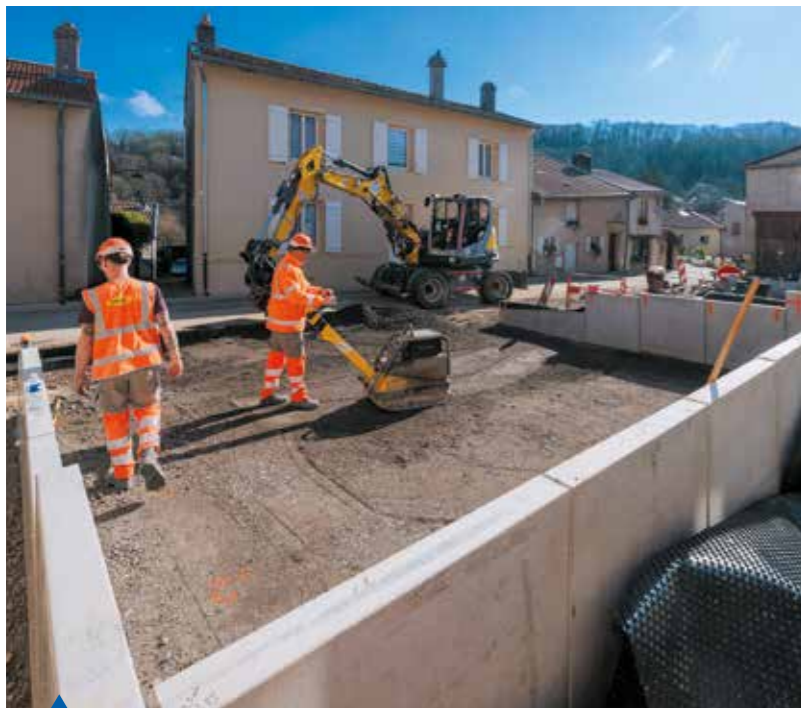
Aménagement de places de stationnement accessibles et de leurs murs de soutènement.
