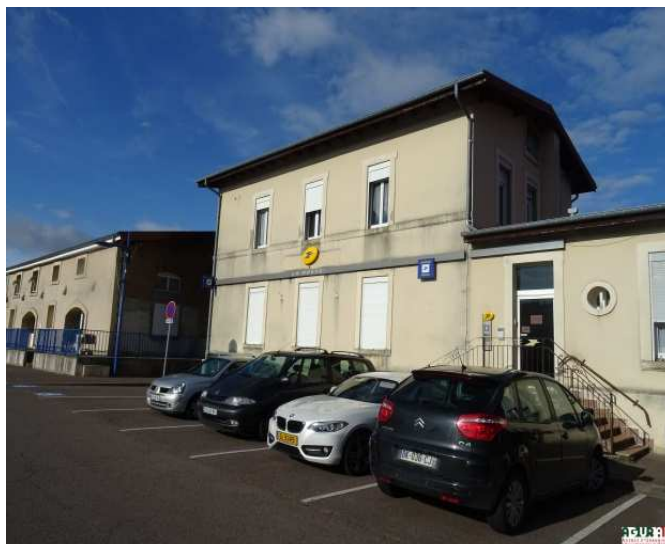
PARKING PUBLIC À PROXIMITÉ DU BUREAU DE POSTE SOUVENT SATURÉ EN JOURNÉE
