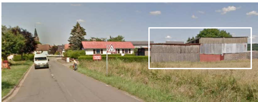
VUE SUR L'AMAS DE TÔLES QUI ACCUEILLE LES VISITEURS À L'ENTRÉE OUEST DE LA VILLE DEPUIS LA RD51
