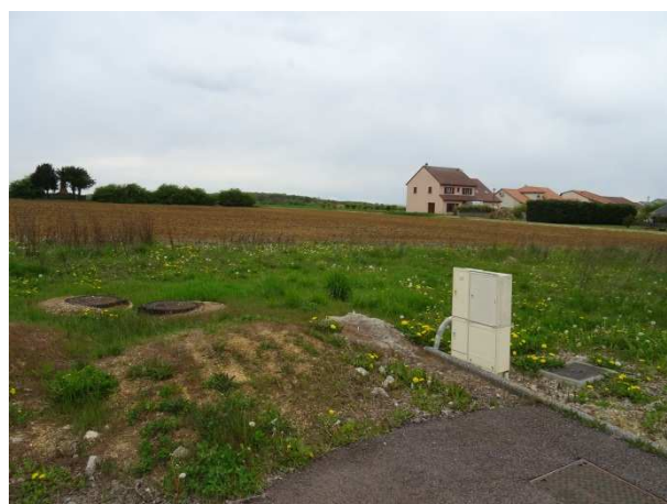
OPÉRATION LA « JUSTICE » TRANCHE N°2 EN COURS DE RÉALISATION
