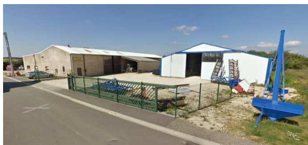
L'ENTREPRISE COSTA DANS LA ZONE D'ACTIVITÉS
