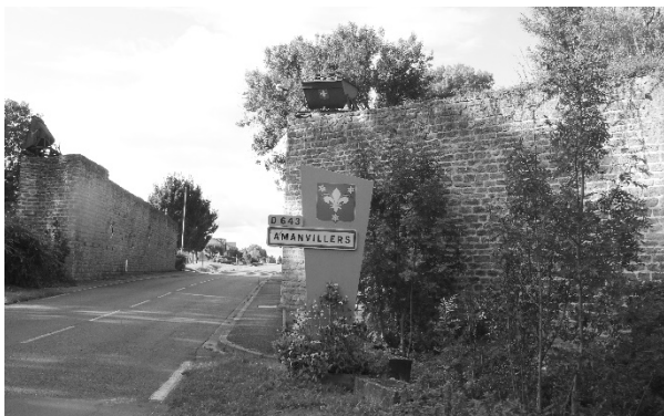
L'ANCIEN PONT FERRÉ EN ENTRÉE DE VILLE RUE DE METZ
