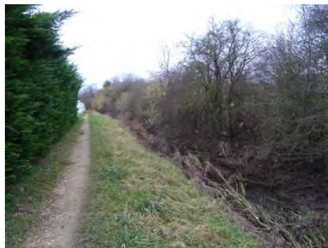
Ruisseau de Montvaux, rue de Montvaux
