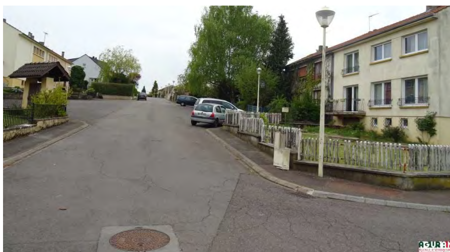
Exemple d'inadaptation de la voirie pour l'accessibilité aux PMR, rue de Champagne
