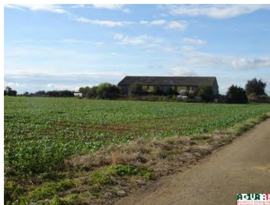
Hangar agricole isolé par rapport au tissu urbanisé
