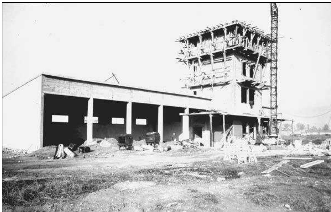
Construction de la tour de contrôle en 1955
