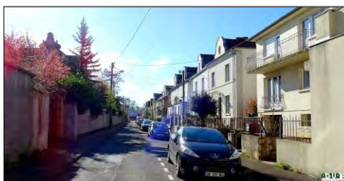
Mur d'enceinte de propriété, rue étroite à sens unique et stationnement délimité sur chaussée
