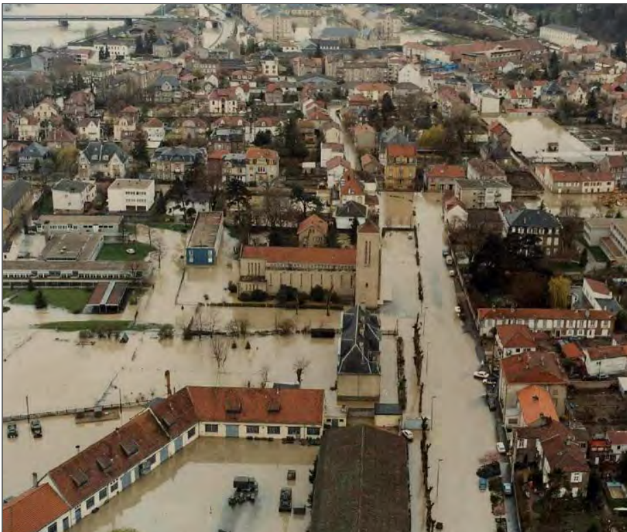
Le risque inondation du Ban-Saint-Martin. Avril 1983, Source DDT57.
