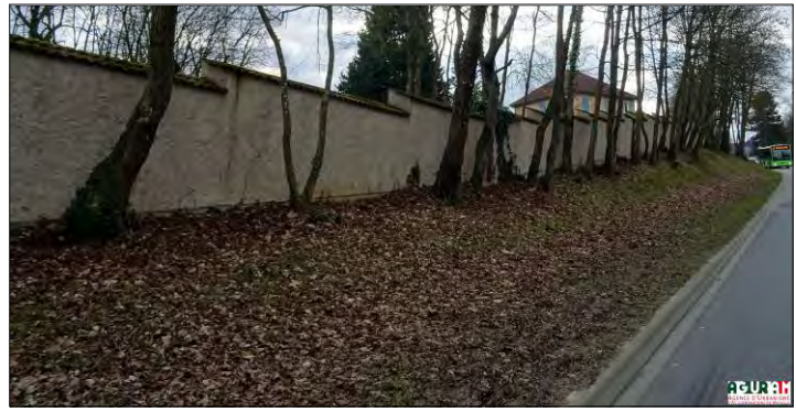
Mur d'enceinte du secteur pavillonnaire
