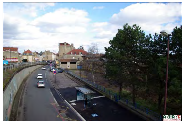
Route Départementale RD 603
