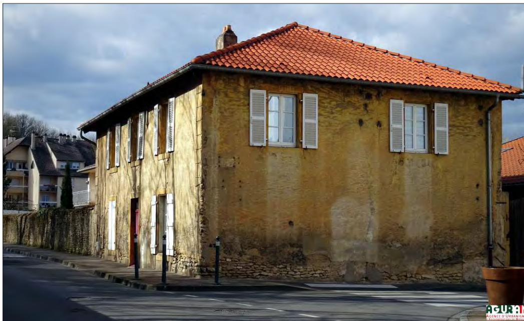
Ancienne bâtisse datant d'avant 1900 dont la qualité et l'intégrité architecturales originelles ont été conservées grâce à des travaux de toiture récents
