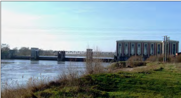
Barrage et usine hydroélectrique d'Argancy
