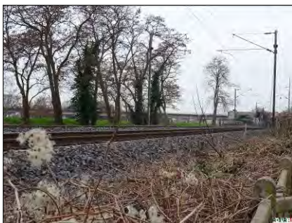
Voie ferrée au Ban-Saint-Martin
