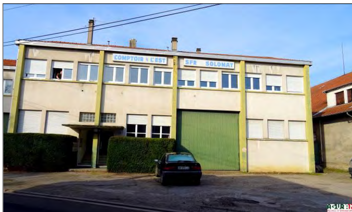
Bâtiment à destination mixte : local commercial et logements
