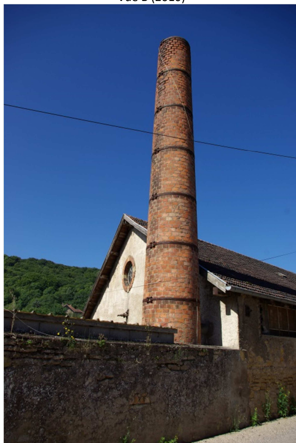
Vue D – (2010) Partie démolie
