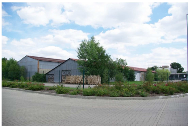
Vue A - Hangars
