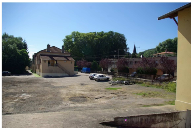
Vue A (2010) – Secteur des travaux en cours
