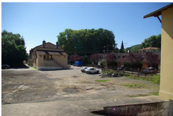
Vue A (2010) – Secteur des travaux en cours
