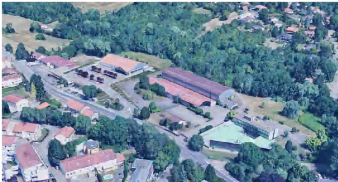
Figure 191 - Vue aérienne de la zone "Le Longeau" (Google-2016)
