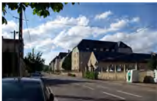
Figure 69 - RD603 et les casernes à Petit Châtel
