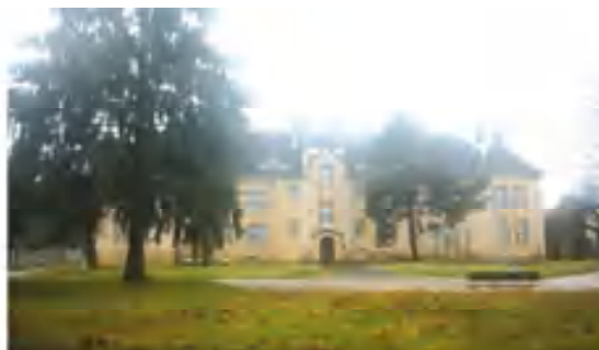
Bâtiment C (mise en service : septembre 2013)
