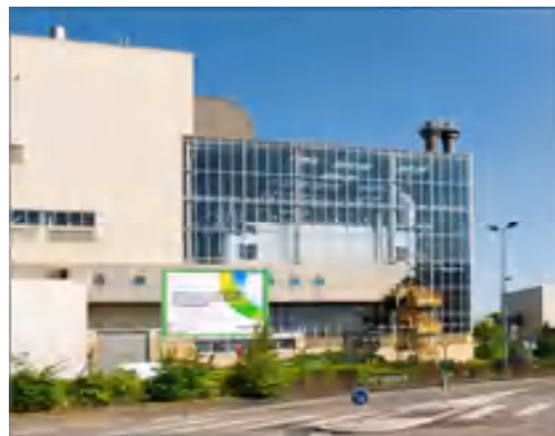
Figure 73 - L'usine de valorisation de Metz-Blida
