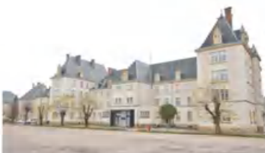
Bâtiment A (mise en service : septembre 2012)
