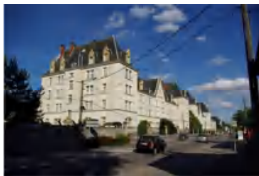
Figure 160 - Caserne Serret Façade Sud - RD603
