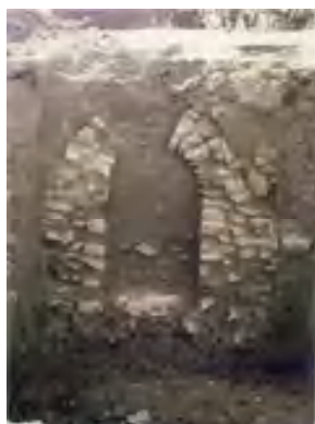
Figure 137 - Aqueduc romain avant fouilles
