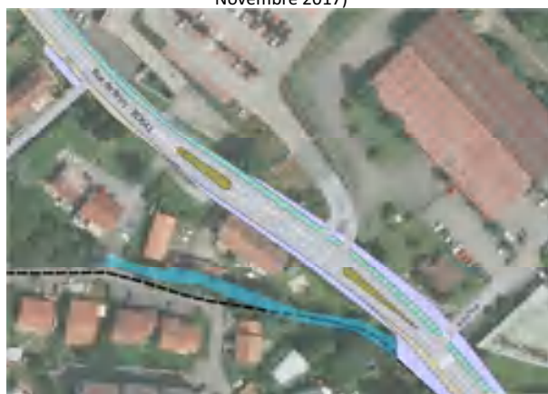
Entrée Sud RD643
