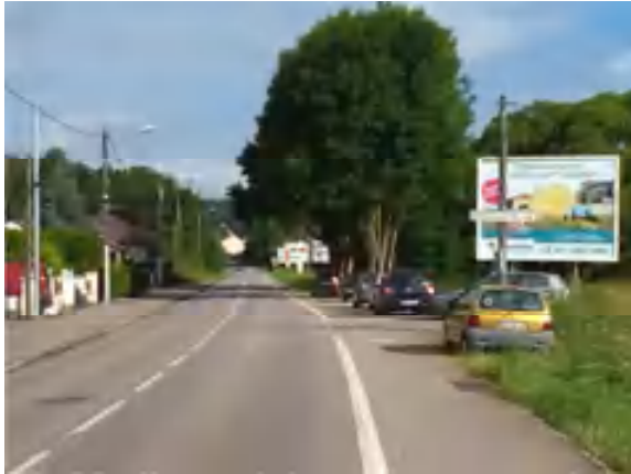
1bis – RD643 Accès Moulin Neuf – Piste cyclable.
