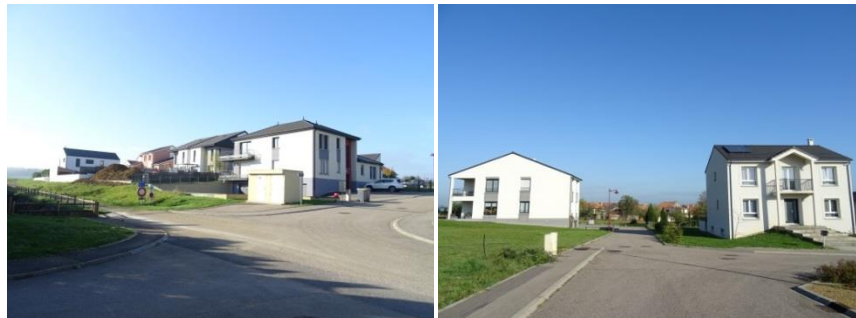
Collectifs construits au sein du lotissement le Maix
