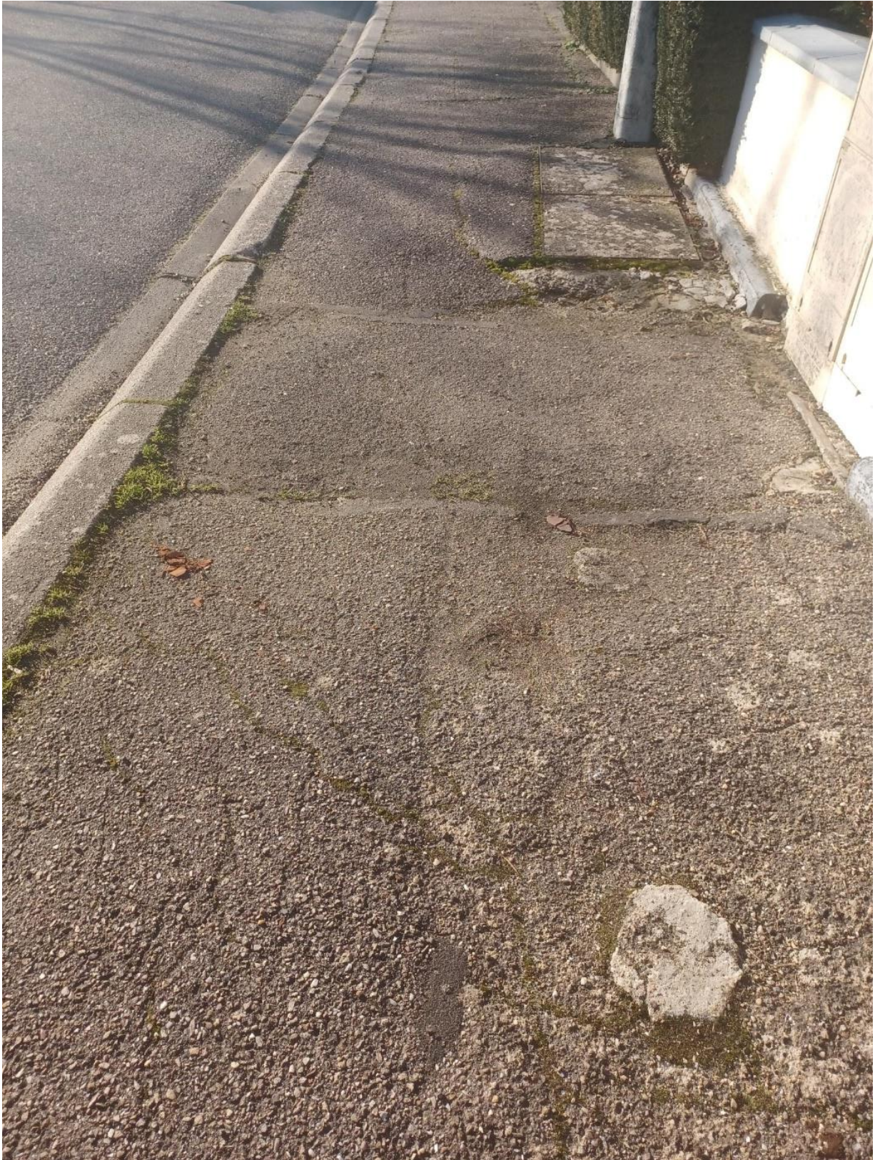
Réseaux secs (téléphoniques et électriques)
