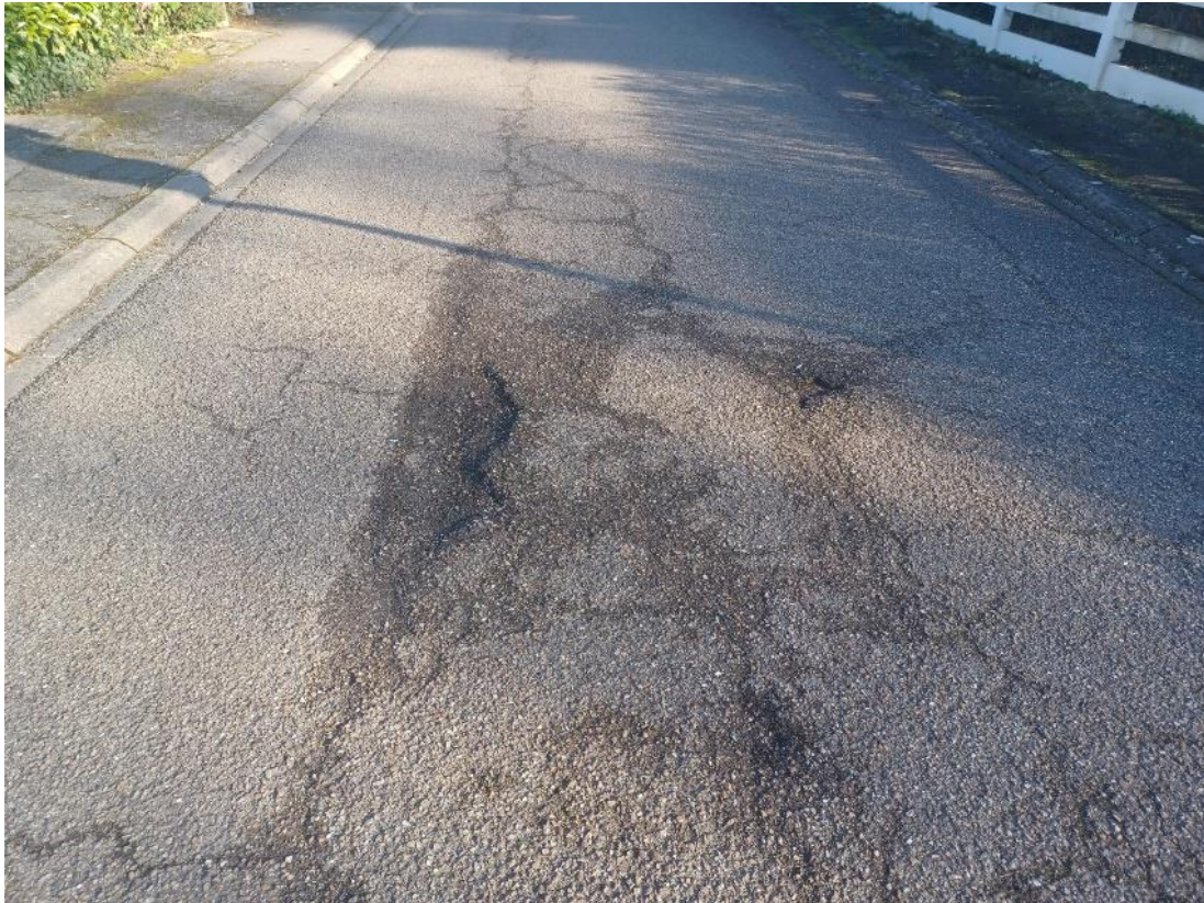
Vue d'ensemble de la chaussée
