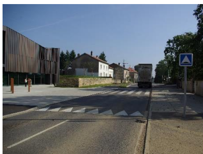
TRAVERSÉE PIÉTONNES SÉCURISÉE
