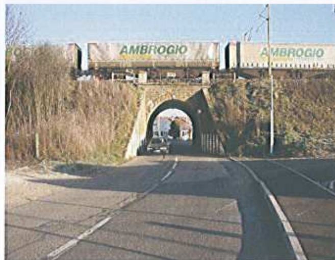
Le tunnel sous la voie ferrée, un lieu de passage
