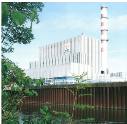
Centrale électrique EDF
