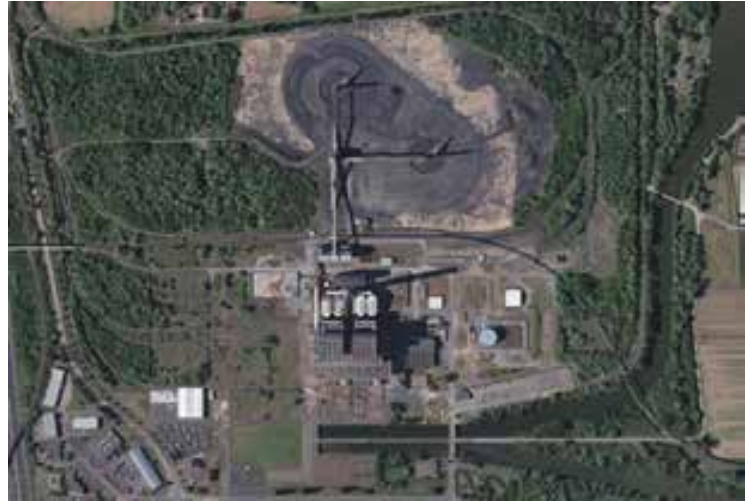
Vue aérienne de la centrale – Source Géoportail
