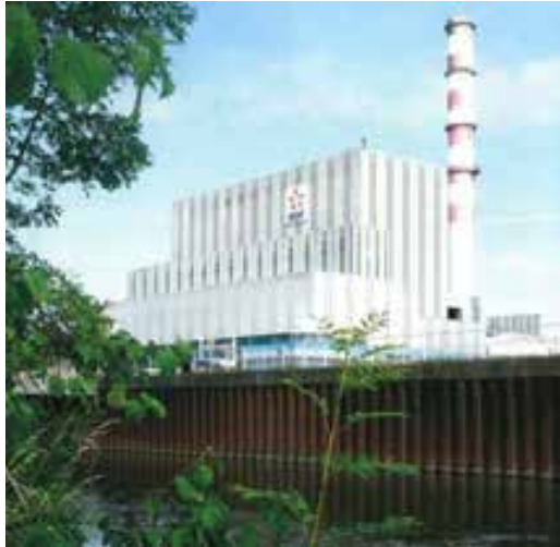
Centrale électrique EDF
