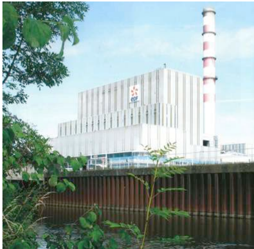
Centrale électrique EDF
