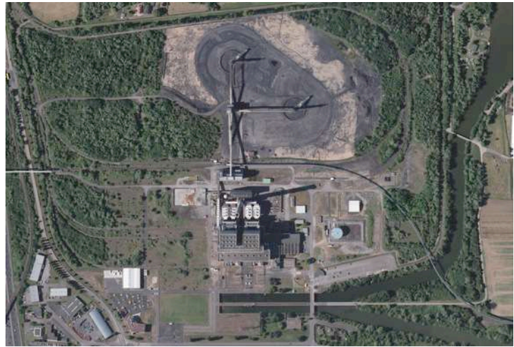
Vue aérienne de la centrale – Source Géoportail
