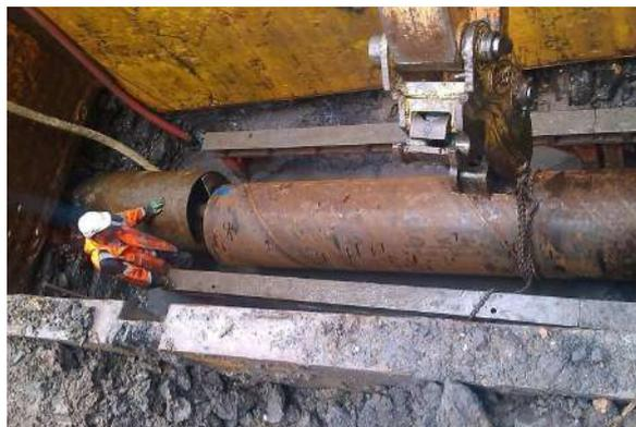
Travaux de mise en place de blindage au niveau des fosses pour le fonçage au niveau de la Seille à METZ
