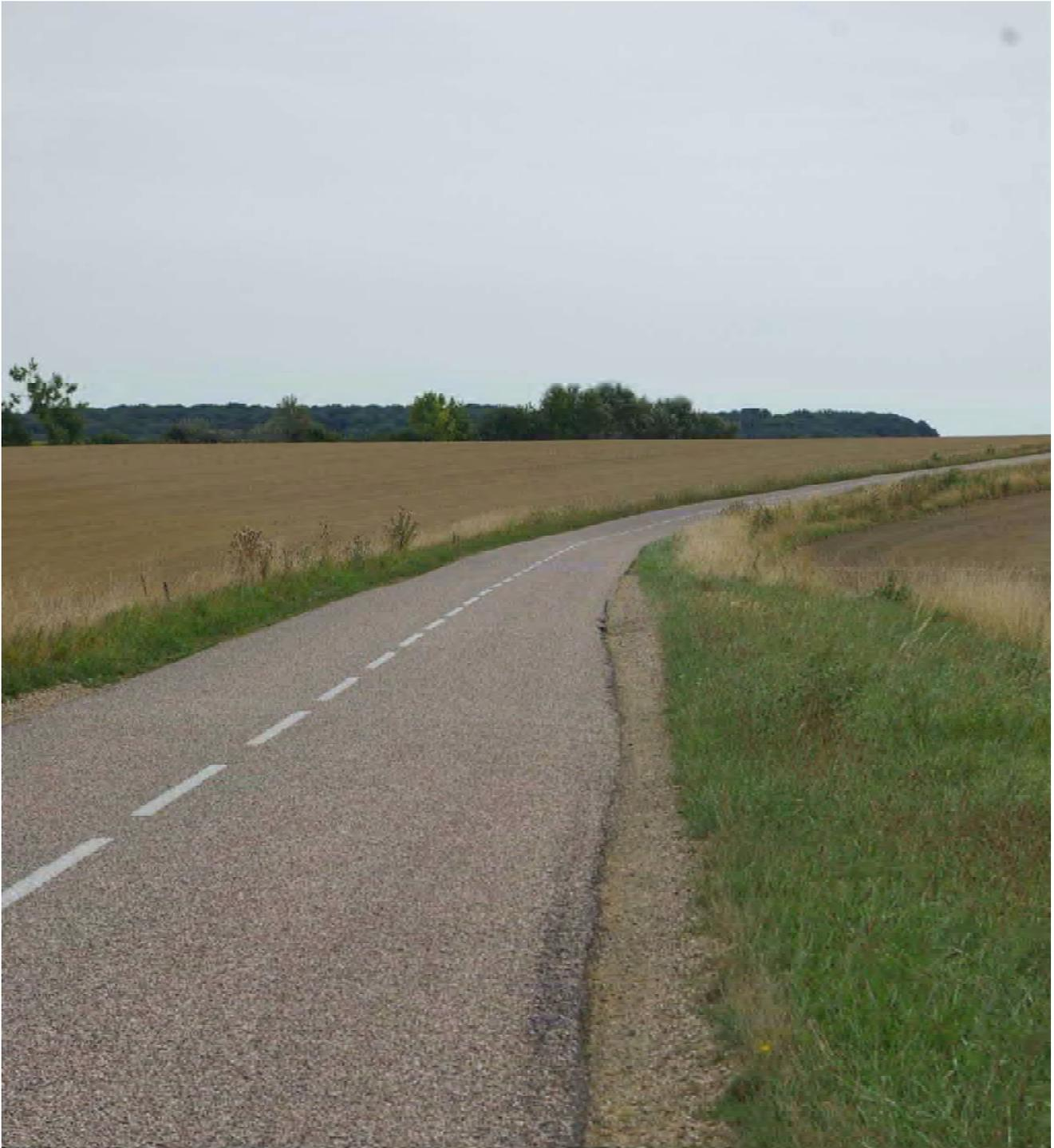
*> Avec un gabarit très étroit et des accotements régulièrement en mauvais état, la RD68a apparaît comme un axe potentiellement dangereux et accidentogène pour ses usagers (Entrée nord-est de la commune)*
