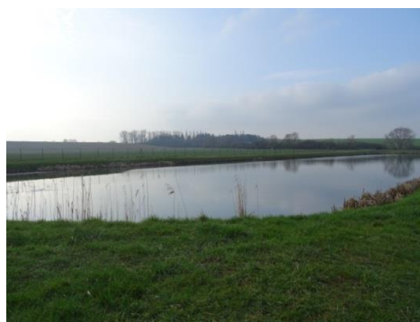
Bassin de lagunage à l'ouest de Lanceumont
