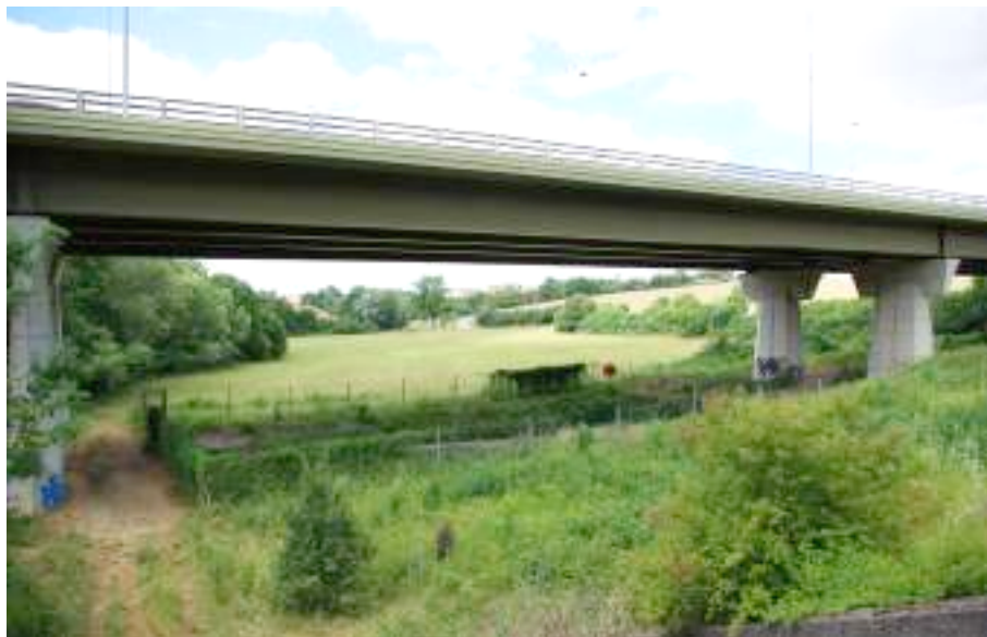
Le vallon du ruisseau de Vallières traversé par l'A4
