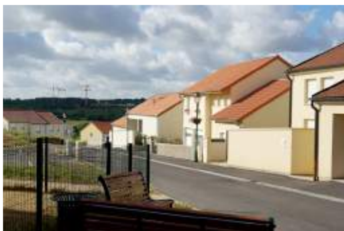
Nouveau village : les murs à rue
