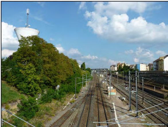
Talus ferroviaire végétalisé
