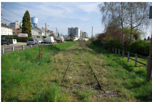
Ancienne voie ferrée Metz – Château Salins
