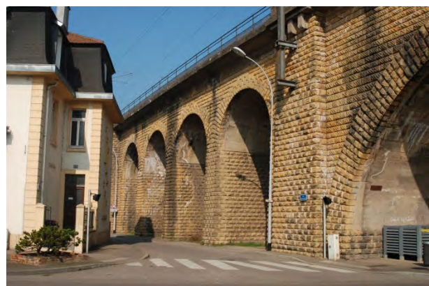
Viaduc au-dessus de la rue de Pont-à-Mousson Secteur Haut Rhèle
