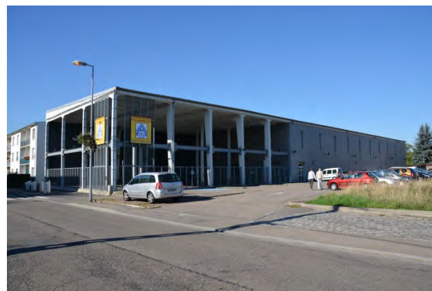
Site Aldi – démolé en 2015
