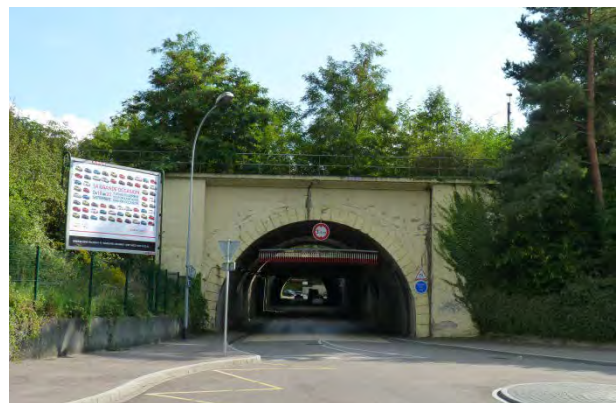
Tunnel de la rue des Lilas
