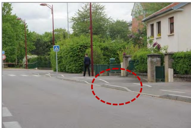
> Fin de l'aménagement dans un virage avec haies engendrant un manque de visibilité pour s'insérer sur la chaussée
