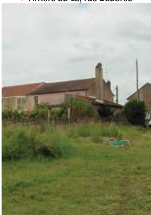
> Arrière du 18, rue Daubrée
