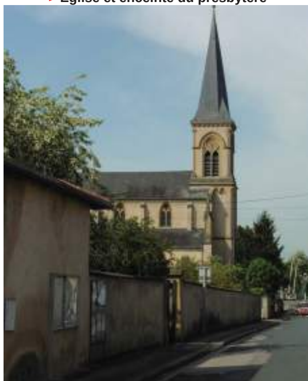
> Eglise et enceinte du presbytère
