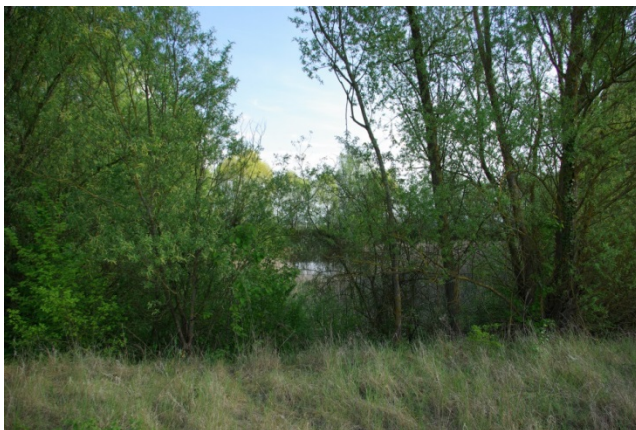
Bassin d'orage situé à Grimont – AGURAM 2014
