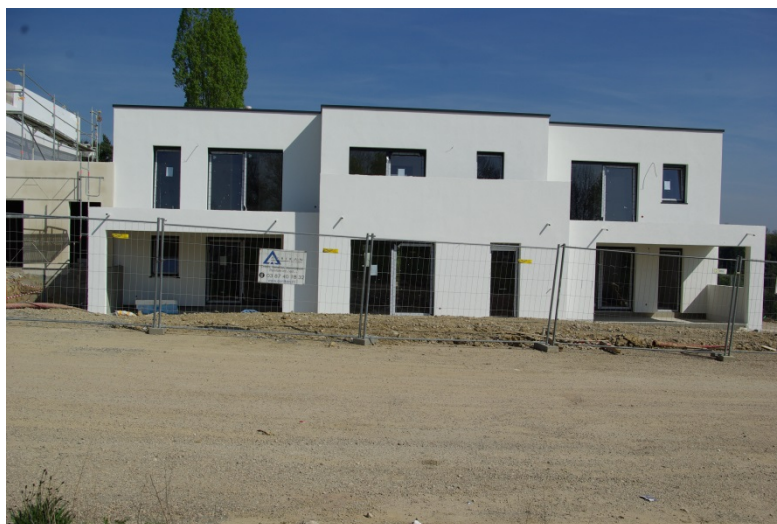
Opération en cours de réalisation sur le secteur de la Sapinière AGURAM - 2014
