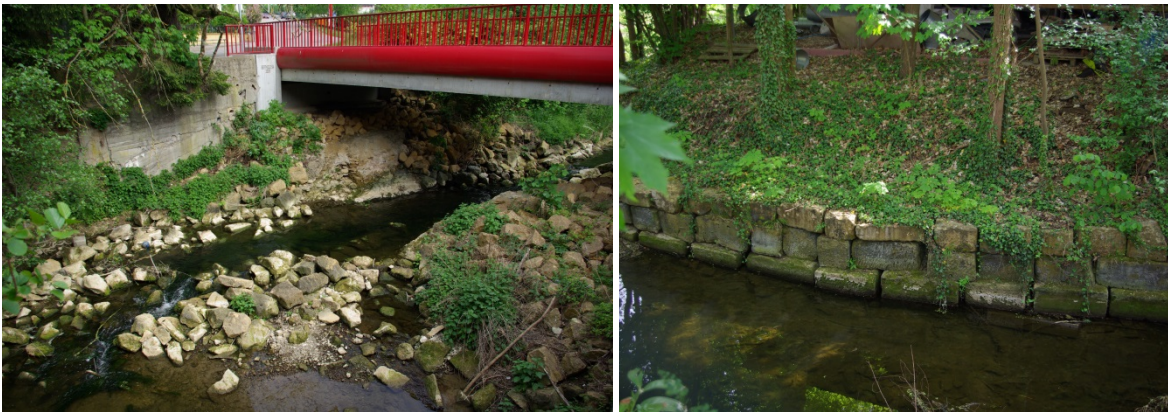
Ruisseau de Vallières : Seuil aménagé (à gauche) – Berge artificialisée (à droite) – AGURAM 2014
