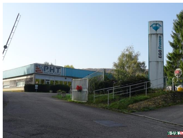
Entreprise d'appareils électroménagers dans la zone industrielle
