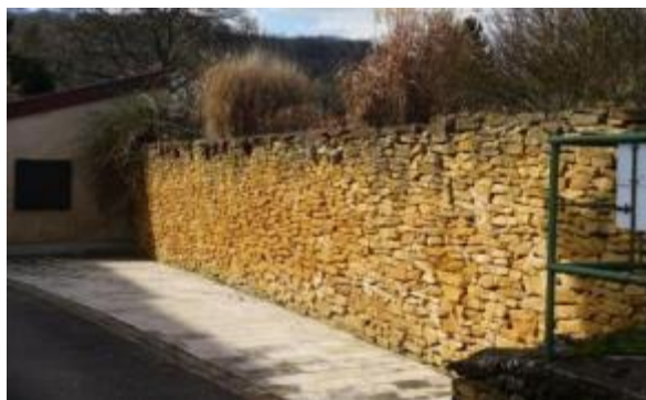
Mur de soutènement en pierres derrière l'église
