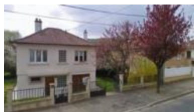
Rue de Metz – Secteur Chadotte Maison de 1960
