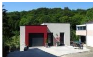
Extension Rue de Briey - Maison cubique récente datant de 2011
