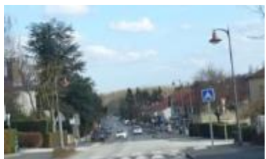
Rue de Metz - Extension urbaine au « coup par coup »
