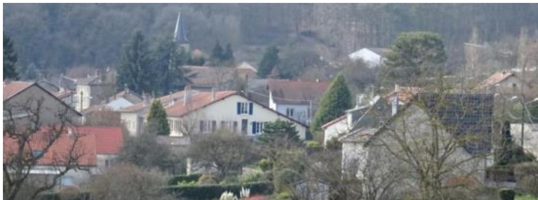
Les bâtiments d'habitations implantés sur le coteau de Saulny
