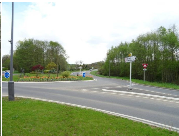
Carrefour à sens giratoire aménagé en entrée sud de Saulny (RD 7 et RD 50a)
