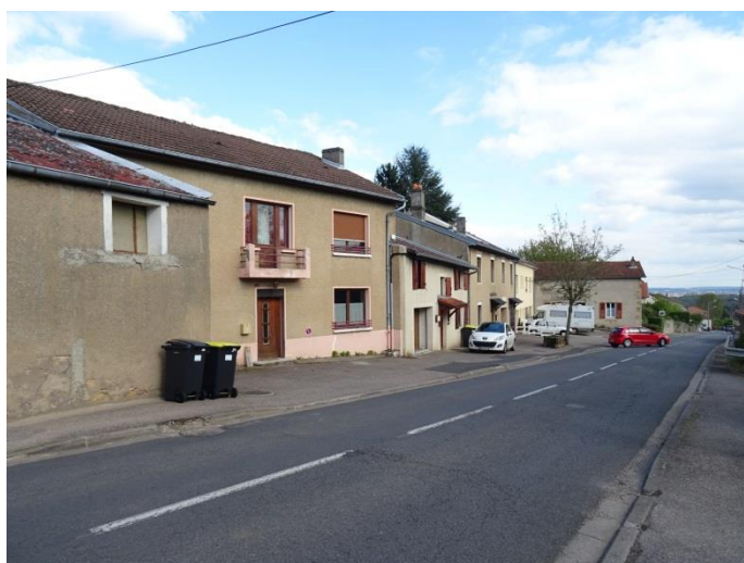
Rue de Metz en partie haute du village correspondant à la RD7 en partie agglomérée
