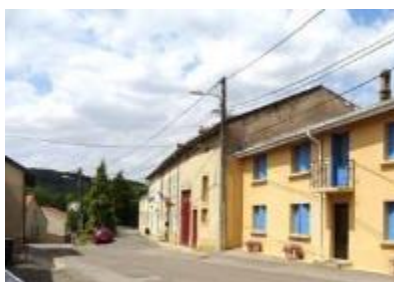
Rue du Château section médiane
