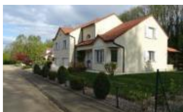
Rue du Moulin - Habitations pavillonnaires diffuses
