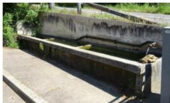
Lavoir/fontaine, rue de Briey en entrée Nord
