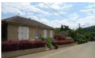
Rue des Courtes Rayes Pavillon sur sous-sol des années 1977
