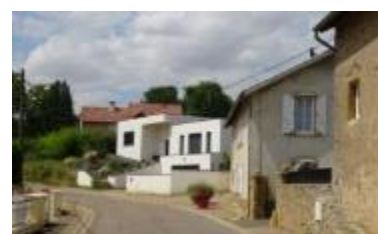
Rue du Château Maison contemporaine de 2012
