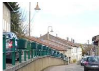
Rue de l'Eglise section Ouest
