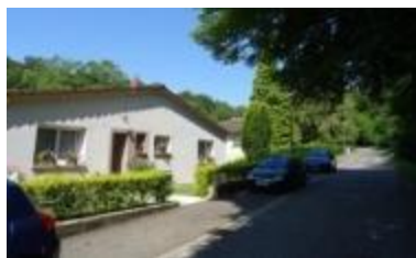
Extension Rue de Briey - Maison en rez de chaussée des années 1970
