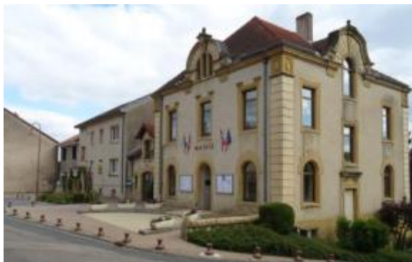
Mairie localisée rue de l'Eglise
