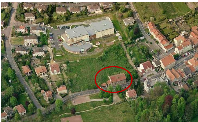
L'ancien bâtiment agricole qui présente un potentiel pour créer de nouveaux logements
