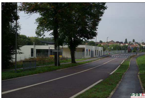
L'école intercommunale achevée
