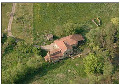
Vue aérienne du Moulin
