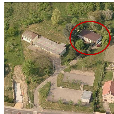
L'ancien logement démonté
