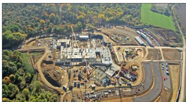
Vue aérienne lors de la construction de l'hôpital
