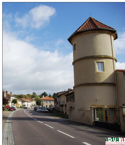
L'ancienne tour, rue Jean-Julien Barbé à proximité de la mairie de Vantoux
