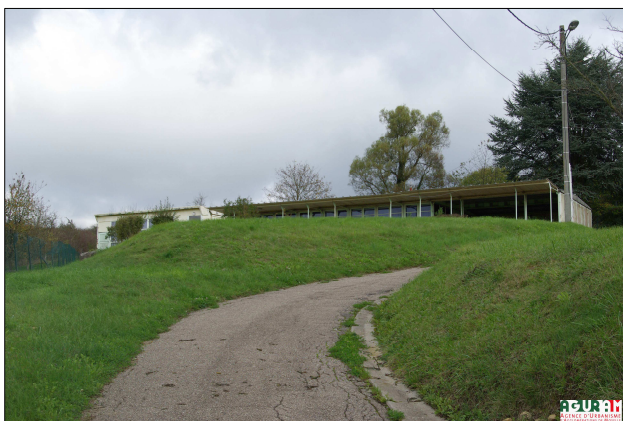
L'accès existant à l'ancienne école
