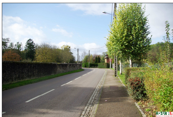
Vue sur le mur en pierres qui ferme le parc
